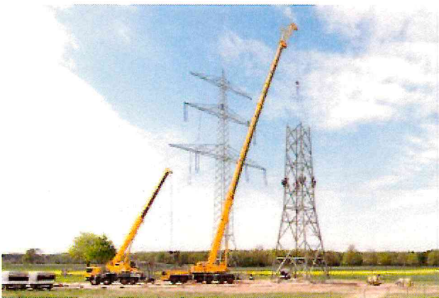
Ein Liebherr-Mobilkran LTM 1300-6.2 der KVN Autokrane GmbH montiert einen neuen Strommast.
